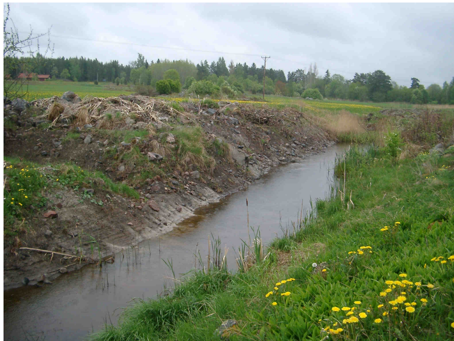
Foto 5. Kraftig rensning nedströms Hillebola. Stora mängder sten, lera och grus har grävts upp ur vattendraget. Lagg märke till att diket, till vänster i bild, mynnar en halvmeter över nuvarande vattenyta.
