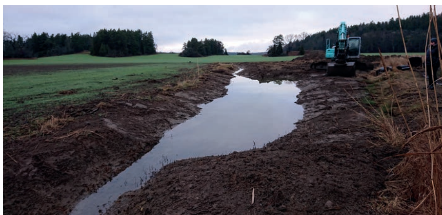
Grävning av näringsfälla
