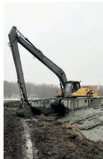
Grävning av näringsfälla vid Hansviken på Håringe.
