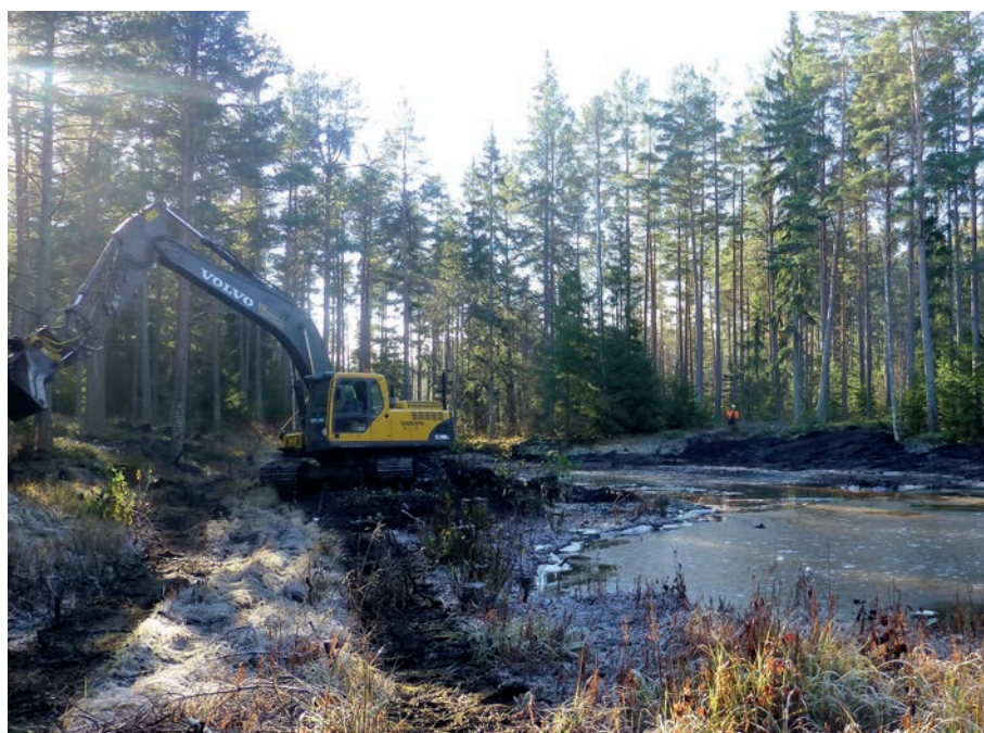
Grävning av våtmarken.
