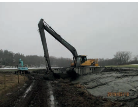
Grävning av våtmark pågår.
