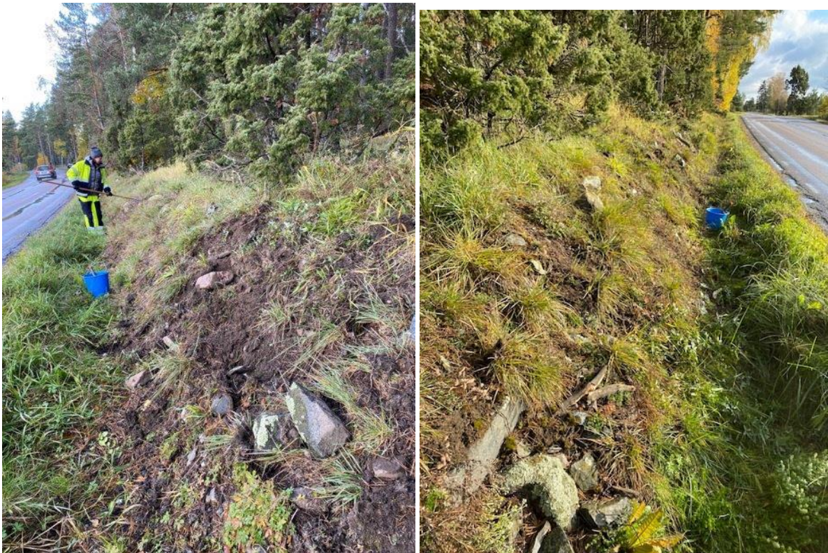
Slänt 4: Tandad skopa plus handkrattning på områden med fin flora.
