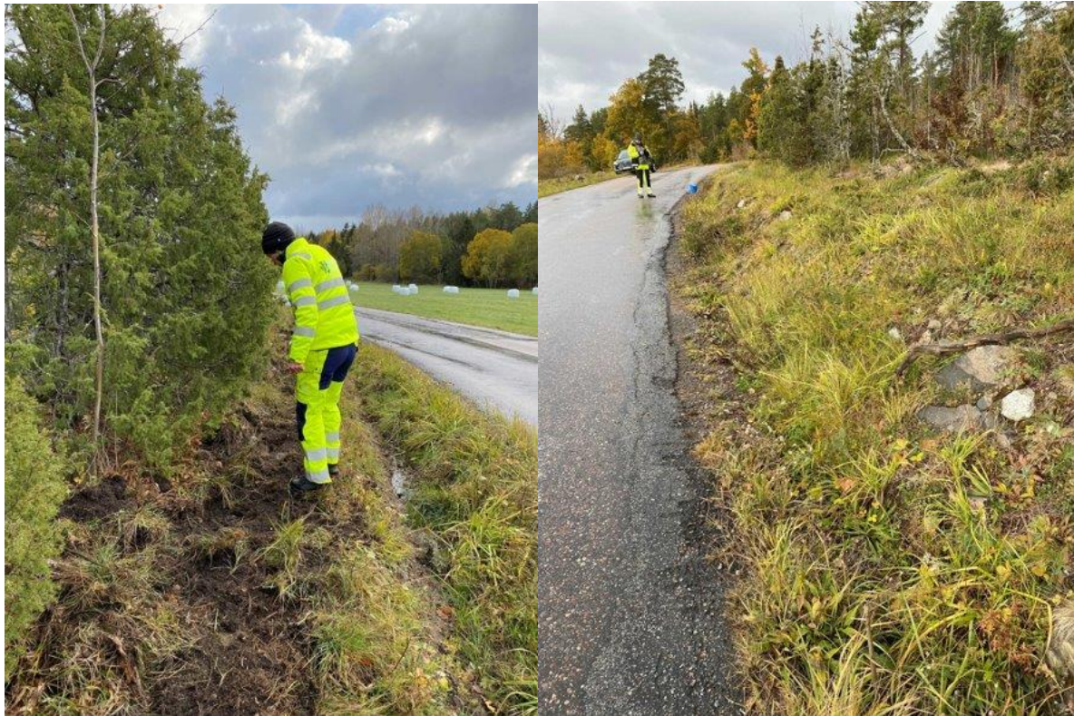
Slänt 6: Tandad skopa plus handkrattning på områden med fin flora. Utsådd av frön på bilden till vänster.
