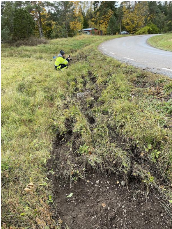
Slänt 3: Tandad skopa plus handkrattning på områden med fin flora.
