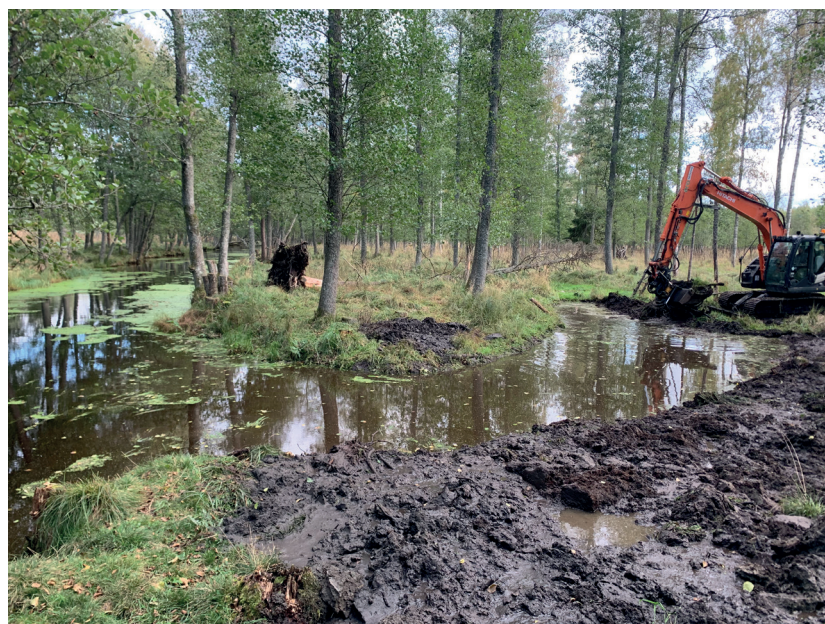
Bild 3. Bäckfåran i Hargsån rätades för länge sedan. En del av restaureringsarbetet har varit att öppna bortgrävda meanderbågar.
