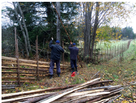
Bygge av gårdsgård på Gräsö hösten 2014. Foto: Anett Wass
