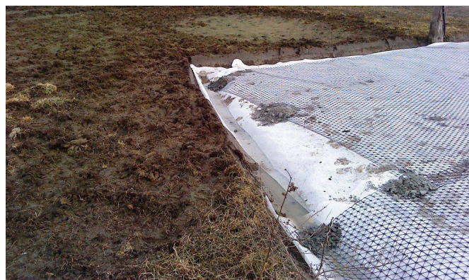
För att förankra kanterna av geotextilen och geonätet, grävs ett dike där kanterna viks ner.
