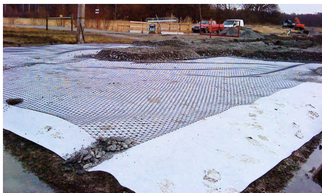
Geotextil och geonät förhindrar att underliggande jord kommer upp i lagret av sand och grus när djuren trampar runt i området. Geotextil läggs ut på en jämn yta. Uppå geotextilen läggs geonätet för att förstärka marken ytterligare.
