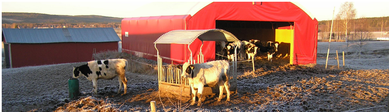
Enkel byggnad (tält) med utfodrings- och bevattningsplats. Marken är förstärkt med geotextil och grus.
