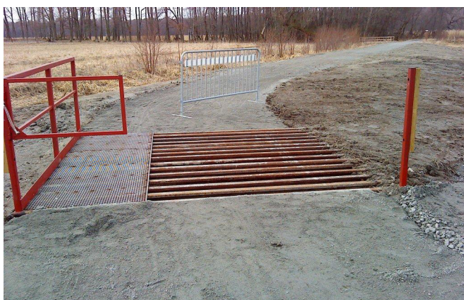
En färist där marken har förstärkts med geotextil.
